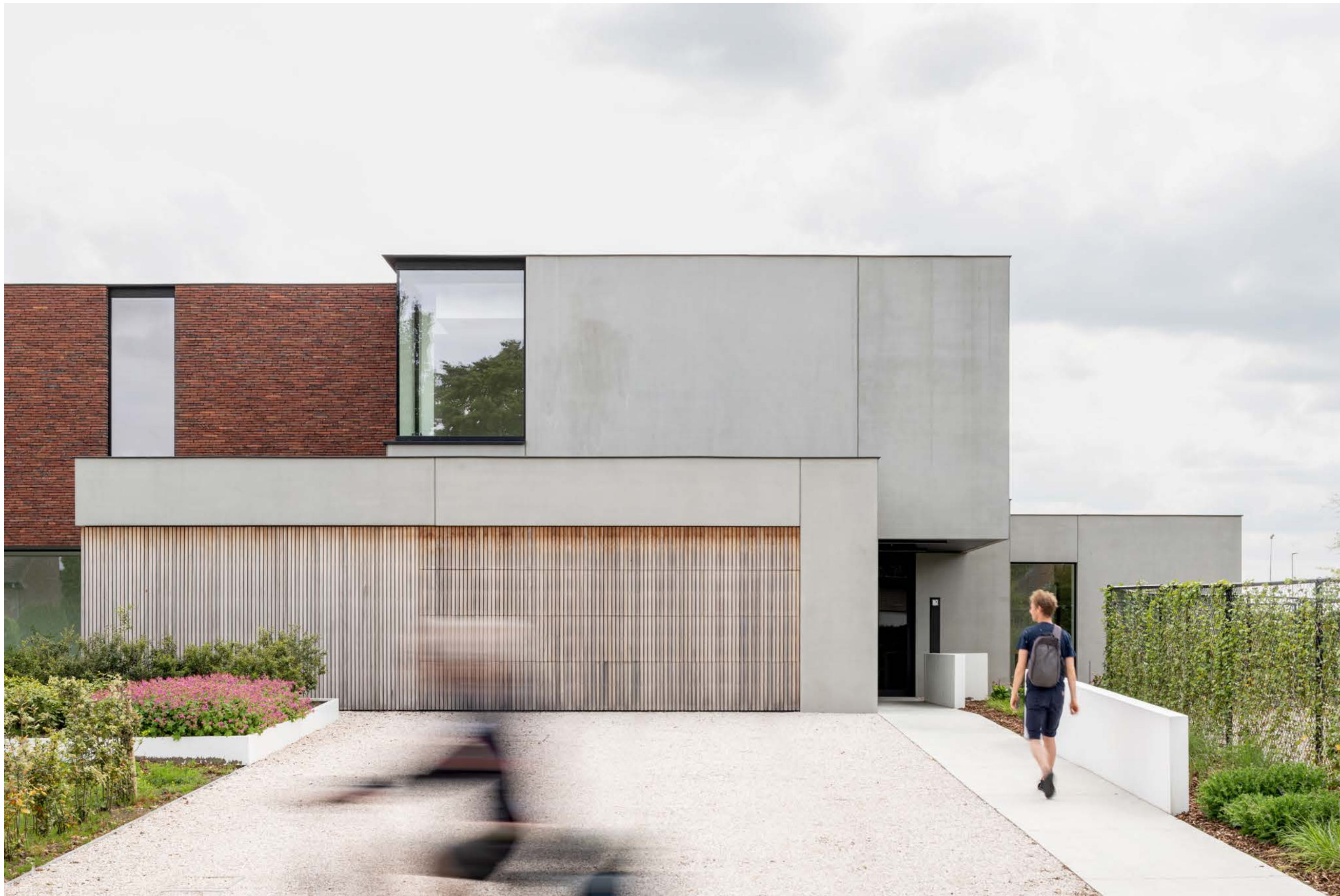
GIJZEGEM (BE) — architect Miranda de Boeck engineering STABICO — contractor SVS bouw Lievens
